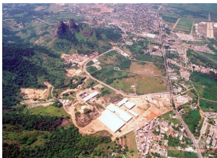
Figura 29: O Projeto Jacarepaguá (Projac) em construção. (REDE GLOBO, 2020)
