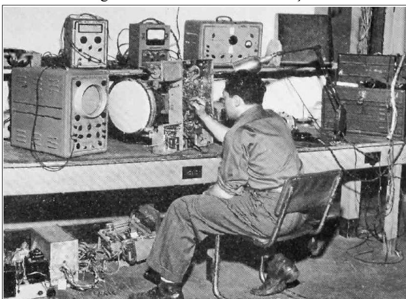
**Na prateleira,** da esquerda para a direita: gerador de varredura, multímetro, gerador de RF.
