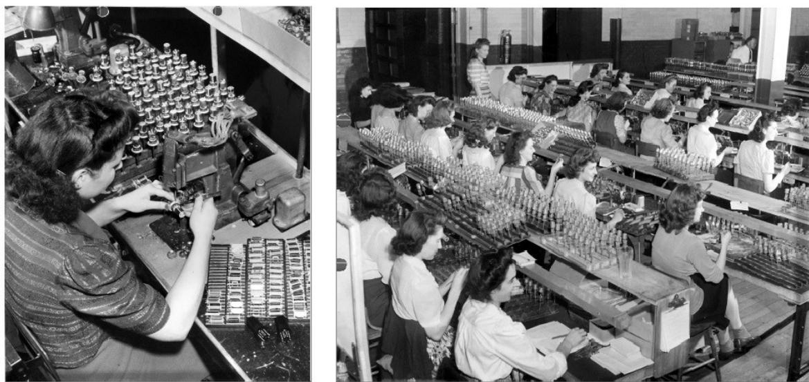
**Esquerda:** trabalhadora soldando os componentes (armazenados abaixo, à direita) para montar uma válvula. **Direita:** trabalhadoras em uma linha de de montagem típica de válvulas (CMC, 2019).
