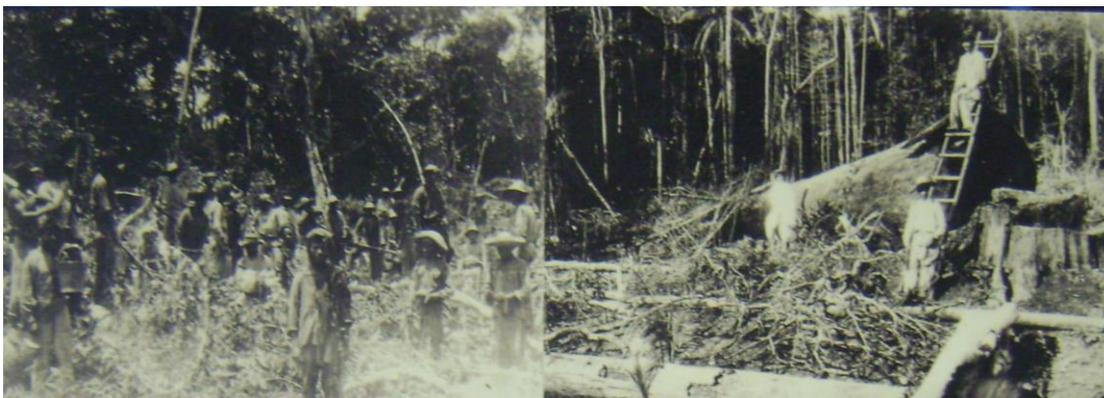
**Fig. 116** – A linha era implantada por sucessivas frentes de trabalho. Atrás vinha a turma que removia troncos e raízes. Fonte: Arquivo Histórico do Exército.
