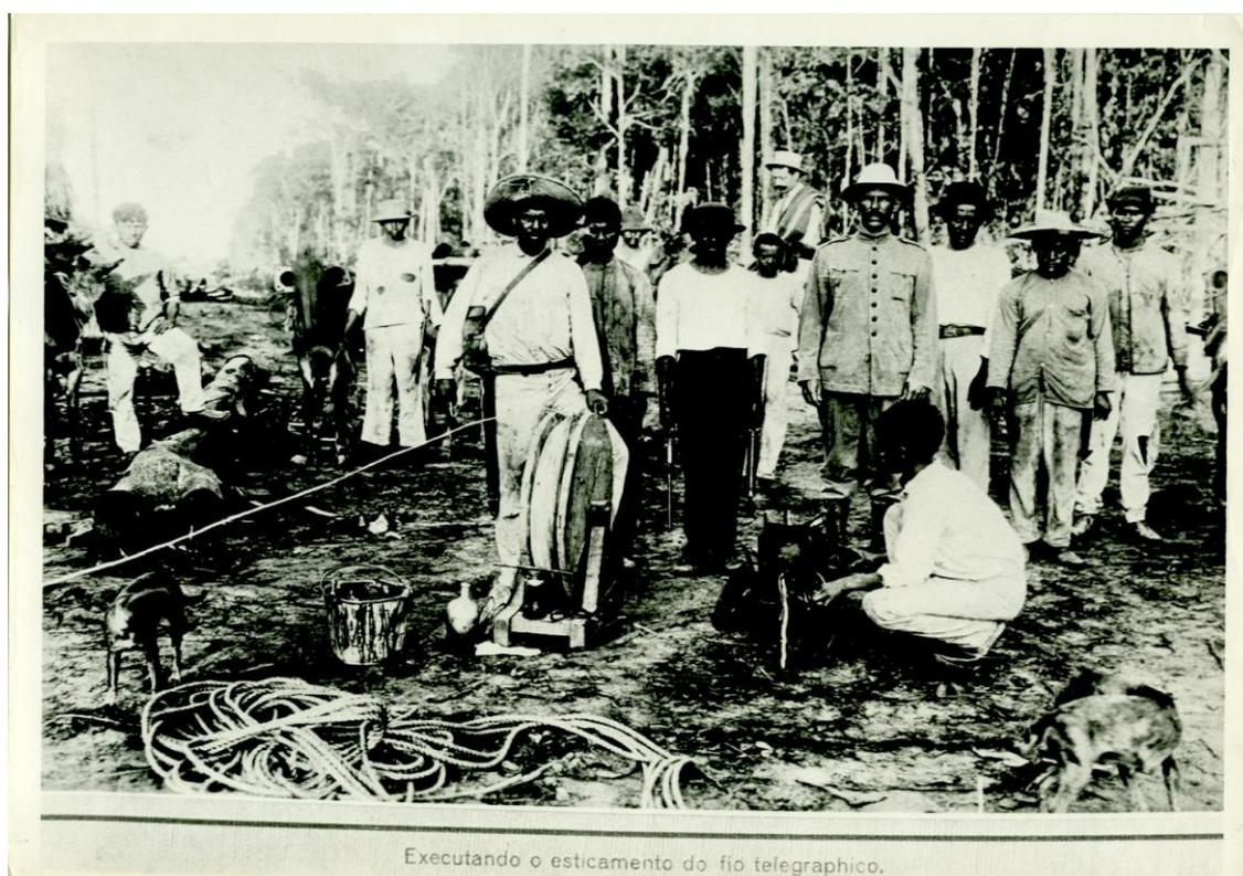
**Fig. 114** – Executando o esticamento do fio telegráfico. Fonte: Museu da Imagem e do Som de Cuiabá. Referência: P.0175 1910.946.4-11.
