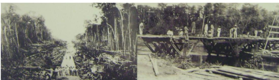
**Fig. 117** – Tinha uma turma que abria a estrada. Sobre rios e depressões se construíam pontes. Fonte: Arquivo Histórico do Exército.
