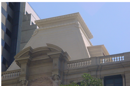
Figura 7 e 8- Estado físico das cúpulas DEPOIS da restauração pontual
