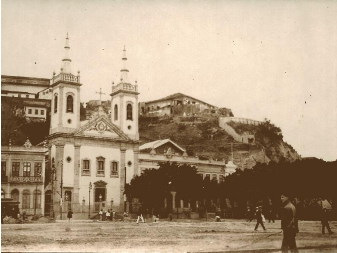
Figura 6: Igreja de Santa Luzia após reforma realizada no século XIX Fonte: https://sanctuararia.art/2017/09/30/igreja-de-santa-luzia-rio-de-janeiro-rj/
