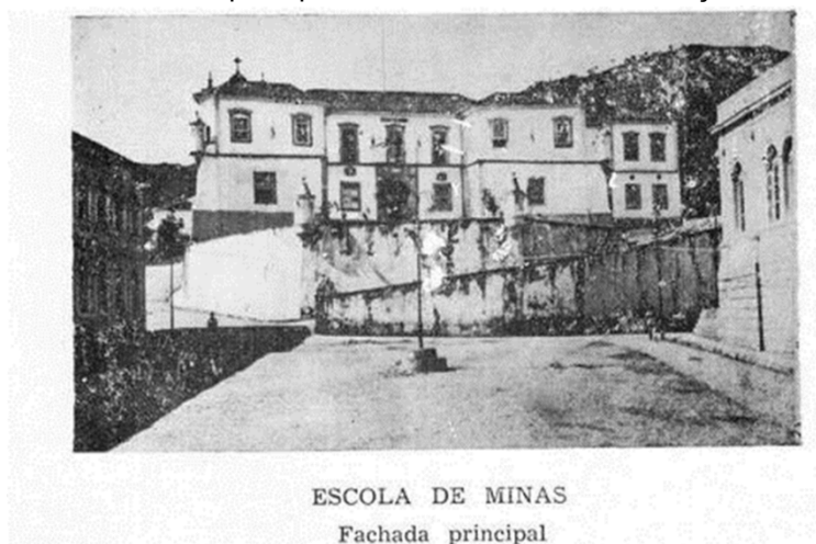
Figura 01 – Fachada principal da Escola de Minas na Praça Tiradentes, centro de Ouro Preto – MG.
