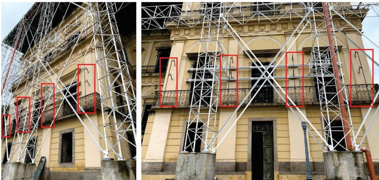
Figura 57 - Suportes para lâmpão no 2º Pavimento. Na imagem à esquerda, os suportes no torreão Sul e na imagem à direita, os suportes no torreão Norte.
