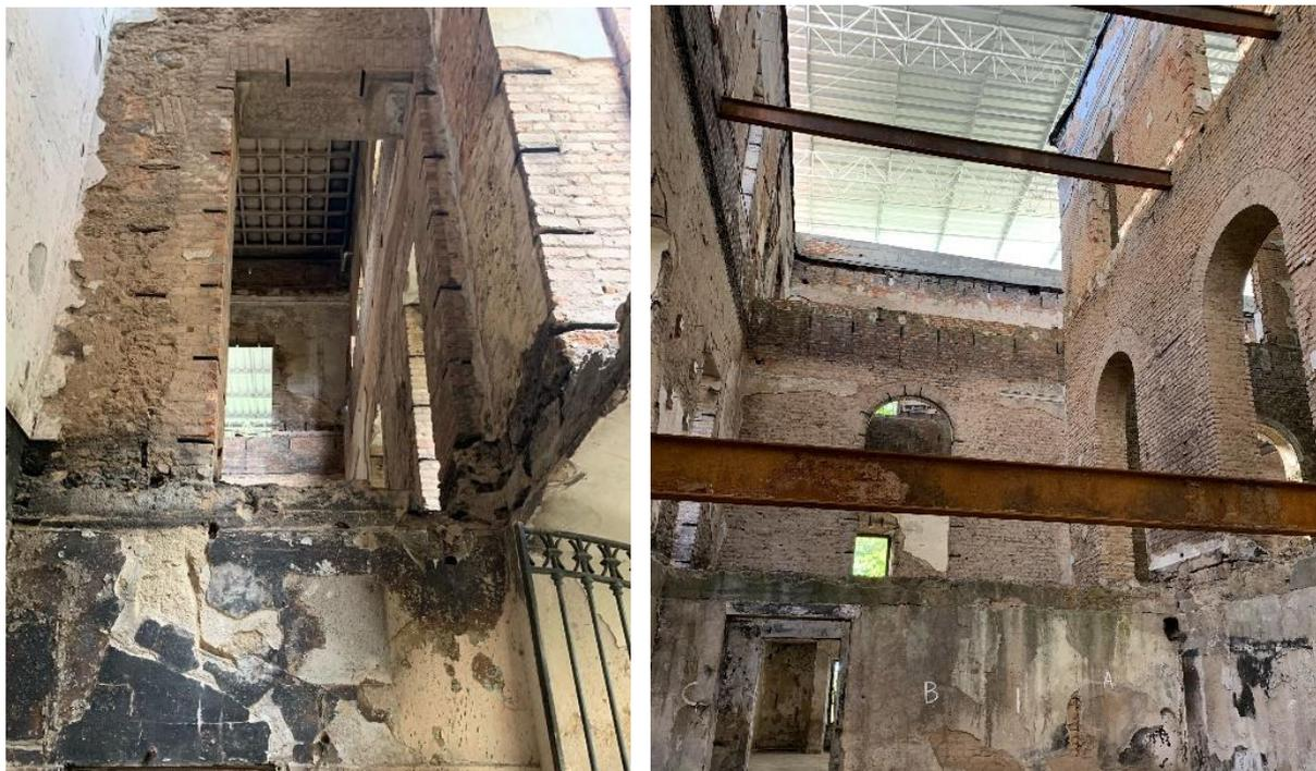
Figura 74 - Exemplos de paredes autoportantes de adobe existentes no Paço.
