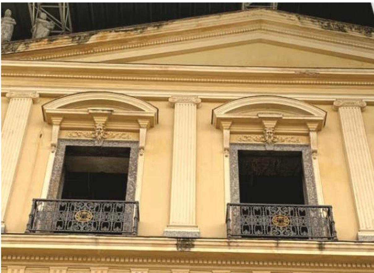
Figura 44 - Gradil do 3º pavimento do corpo central com medalhão com as iniciais PII.
