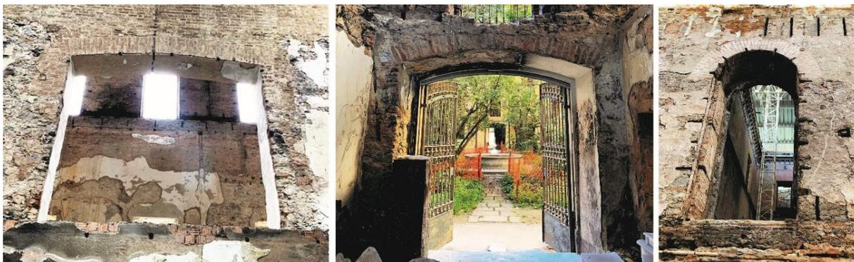
Figura 68 - Exemplos de paredes autoportantes de pedra com arcos em tijolo maciço no Paço.
