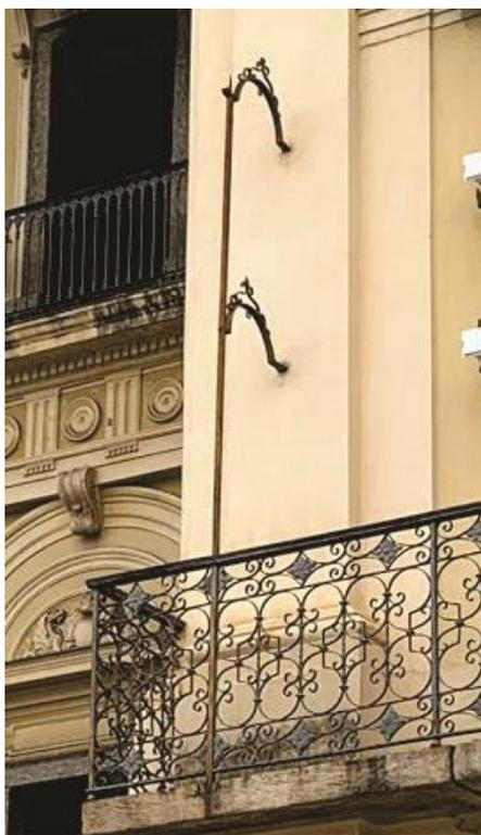
Figura 58 - No detalhe, os antigos suportes para lâmpões.
