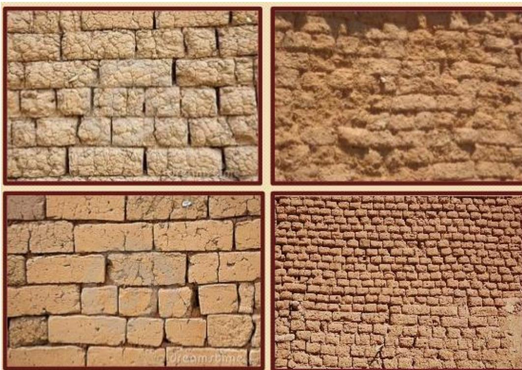
Figura 73 - Exemplo de parede autoportante de adobe.
