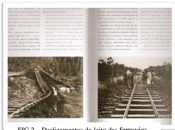
FIG 2 – Deslizamentos do leito das ferrovias
