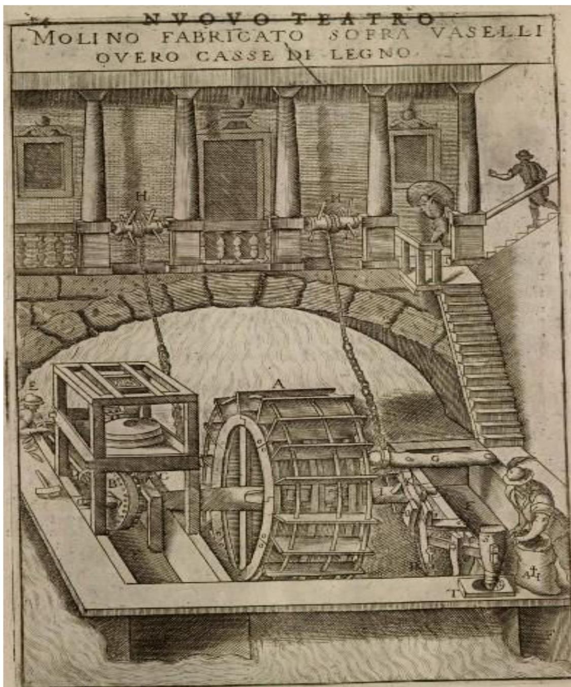
**Figura 4.26:** Estampa de Vittorio Zonca (*Novo teatro di machine et edificii*, 1656), expondo as diversas aplicações dos engenhos rasteiros. À esquerda, próximo ao moinho, afia-se lâminas e no canto inferior direito, há um martelo hidráulico. **Fonte:** (<http://echo.mpiwg-berlin.mpg.de>)
